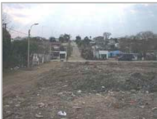
Fig. 18: Predio R. Rincón, posterior a la demolición y previo a trabajo de remediación. Fuente: IMM.
