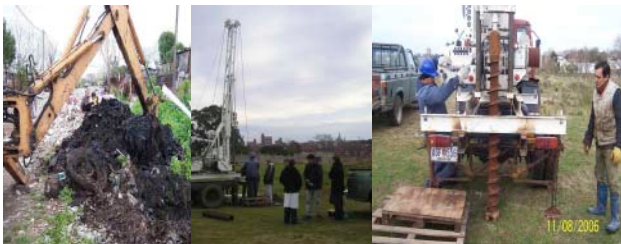
Fig.9: Retroexcavadora. Fig. 10: Perforadora rotatoria. Fig. 11: Herramienta saca testigo
