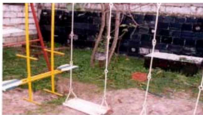
Vista del patio con muro construido de carcasas de baterías
