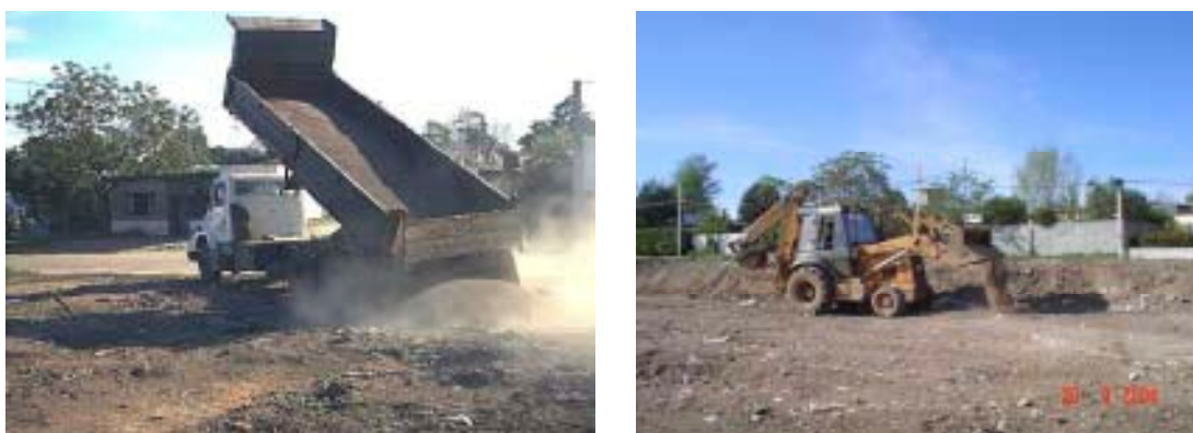
Fig. 26-27: Aplicación de fosfato-apatita a sitio contaminado (R. Rincón), a través de 5 aplicaciones sucesivas de 7 toneladas de producto en un área de aproximadamente 5.000 m 2 . Fuente: Laboratorio de Calidad Ambiental (Intendencia Municipal de Montevideo), año 2004.
